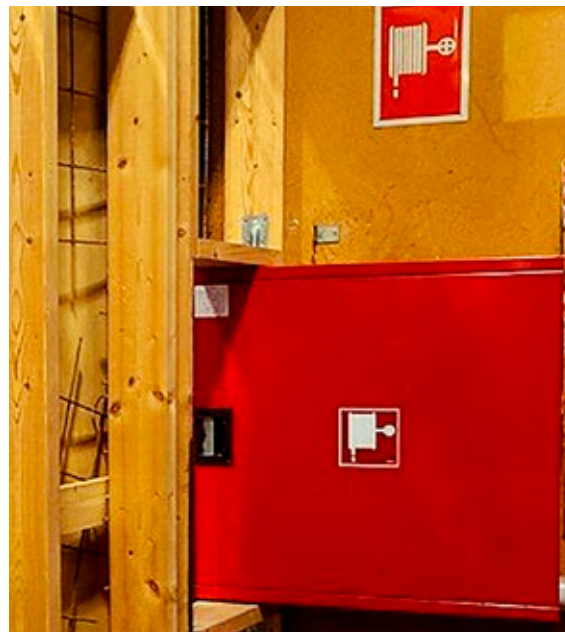
Efter opdeling af en garage er der ikke længere adgang til brandskabet i den ene halvdel.
